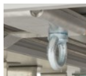
Zugöse für Verlastung mit einer Seilwinde
